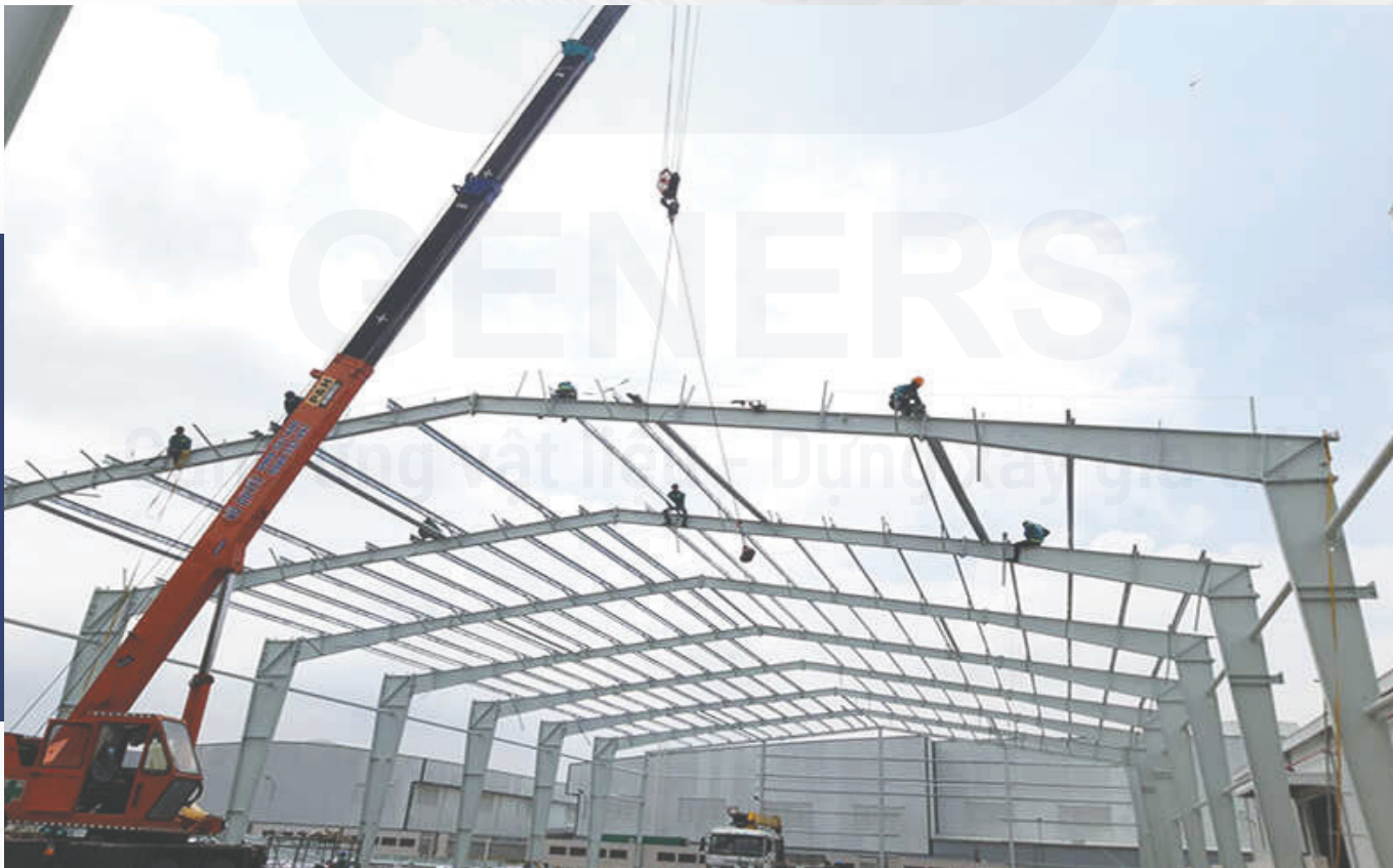
➤ Thi Công Công Trình Nhà Máy Và Tòa Cầu Công Nghiệp
